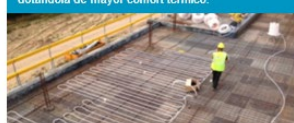
THERMAFLOW, EL HORMIGÓN QUE MEJOR CONDUCE LA ENERGÍA Thermaflow optimiza la termoactivación de forjados y la capacidad de transporte de energía en distribución eléctrica.
